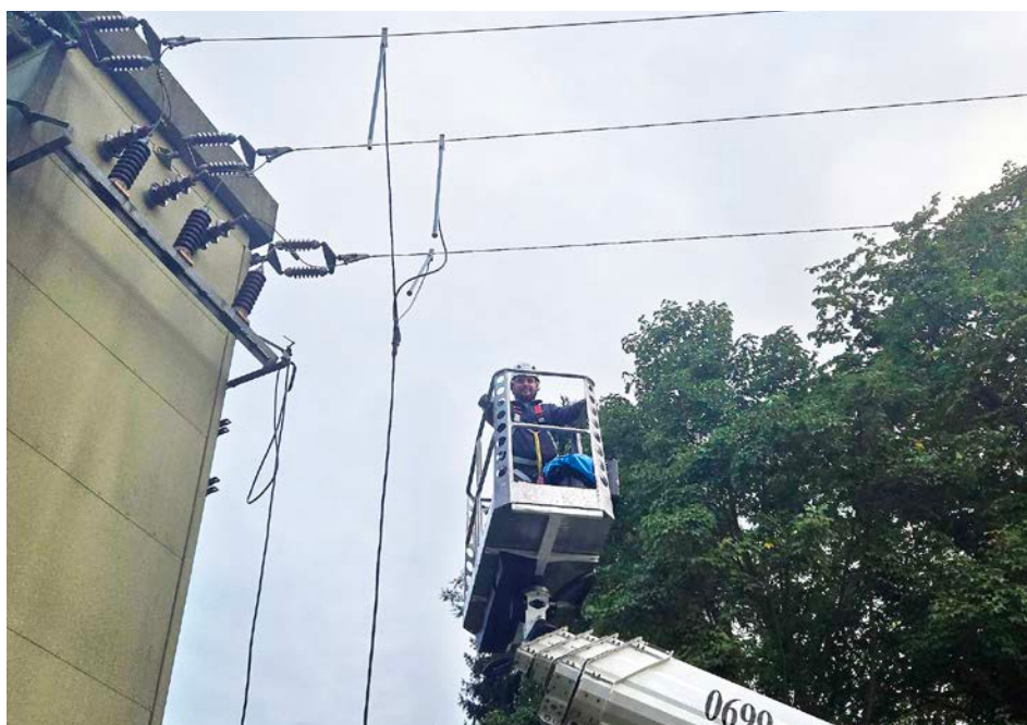
Gut gesichert am Köpplingberg
